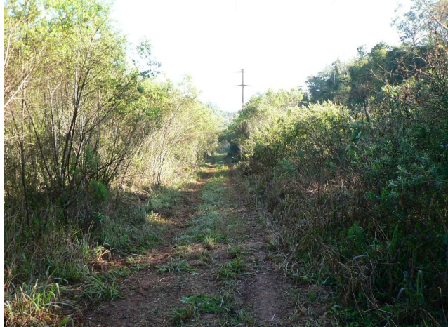
Figura 4: Camino por línea de Alta Tensión
